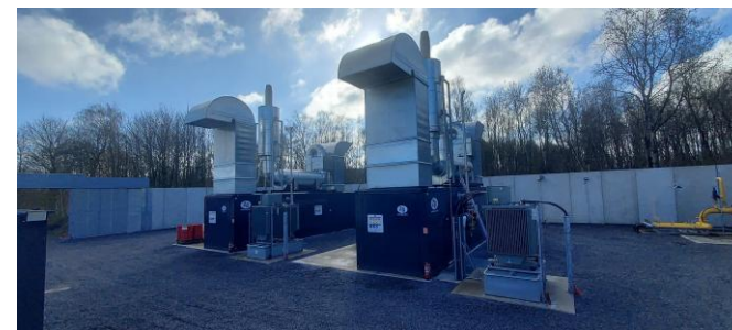
Installation finalisée à Angres Nord de la France
