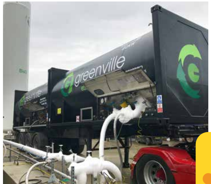
L'installation Greenville Energy en Irlande du Nord : épuration du biogaz, liquéfaction du biométhane et valorisation du CO 2 pour approvisionner en Bio-GNL deux clients industriels qui produisent, grâce à des centrales de cogénération, de l'électricité renouvelable et de la chaleur hors réseau.
