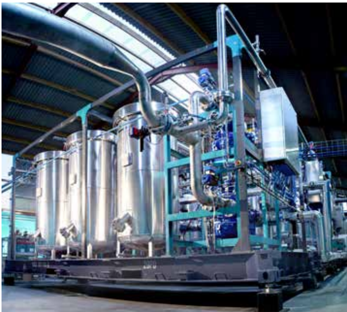
L'installation Greenville Energy en Irlande du Nord : épuration du biogaz, liquéfaction du biométhane et valorisation du CO 2 pour approvisionner en Bio-GNL deux clients industriels qui produisent, grâce à des centrales de cogénération, de l'électricité renouvelable et de la chaleur hors réseau.
