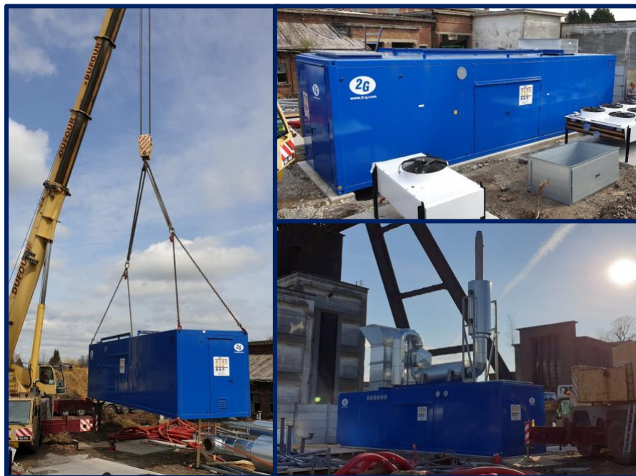
Installation du moteur de 1,5 MW sur le site d'Anderlues
