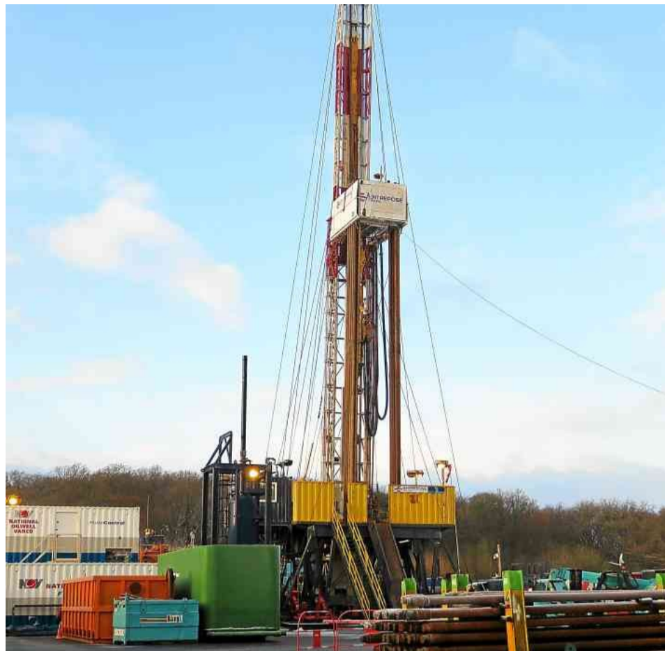
La plateforme de Lachambre fait évoluer une quarantaine de salariés en rotation 24h/24 sur le site. Une fois le forage achevé, il ne restera qu'une tête de puits de quelques mètres de hauteur. (Photo : LFDE)
